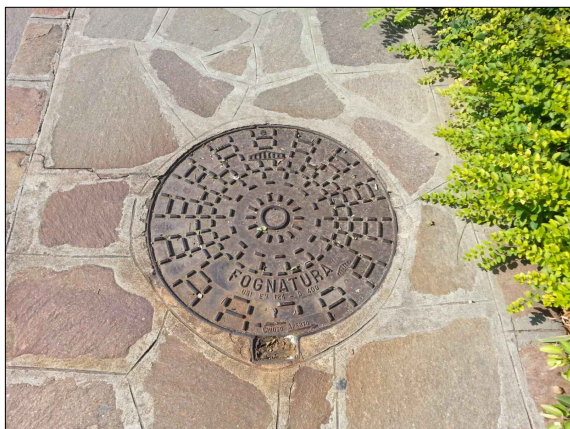
Foto 1 - Botola in ghisa sferoidale
