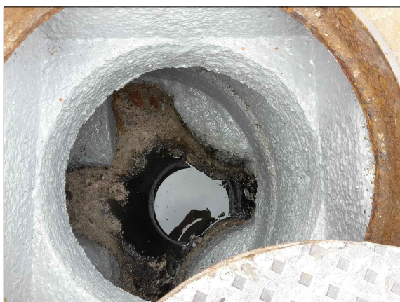
Foto 7 - Ripristino pareti e fondo con resina epossidica
