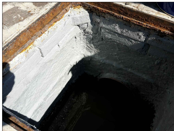
Foto 6 - Ripristino pareti e fondo con malta cementizia
