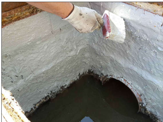
Foto 5 - Ripristino pareti e fondo con malta cementizia
