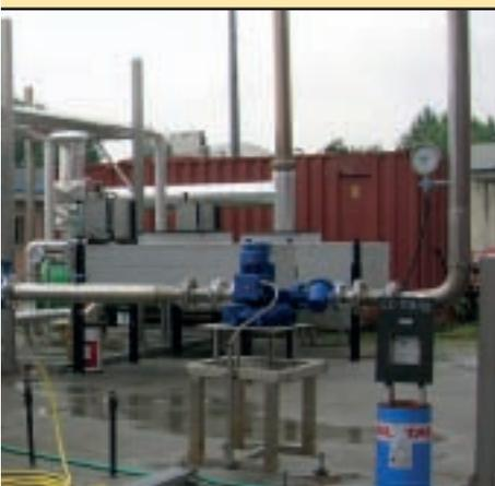
**L** 27 marzo è iniziata la produzione presso il nuovo impianto di cogenerazione alimentato da biogas proveniente dalla sezione di digestione anaerobica di fanghi dell'impianto di depurazione di Carpi.
