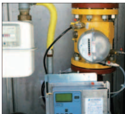
Esempio installazione su gruppo di misura a turbine
