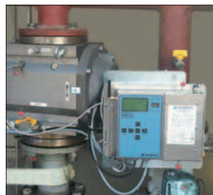
Esempio installazione su gruppo di misura a rotoidi
