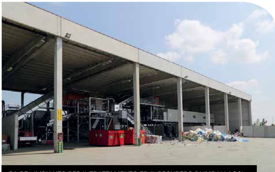
CA.RE.: IMPIANTO PER IL TRATTAMENTO ED IL RECUPERO DI IMBALLAGGI
