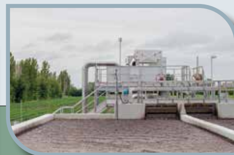
Nuovo Depuratore di Poggio Rusco
