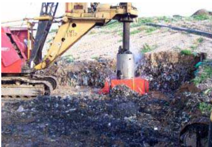
Fig. – fase di trivellamento con la “protezione a giro” intorno alla bocca-pozzo,
