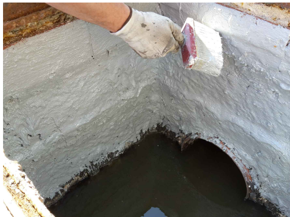
Foto 5 - Ripristino pareti e fondo con malta cementizia
