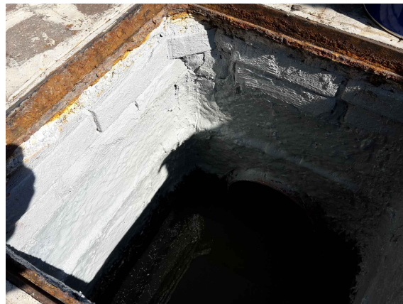
Foto 6 - Ripristino pareti e fondo con malta cementizia
