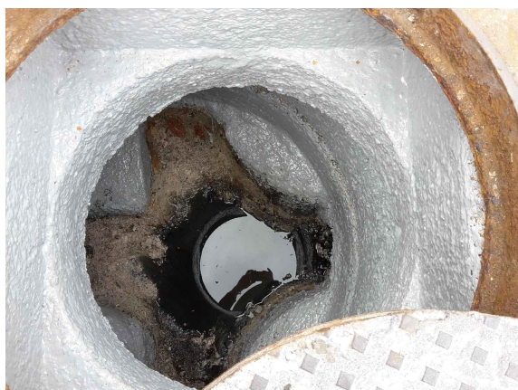
Foto 7 - Ripristino pareti e fondo con resina epossidica
