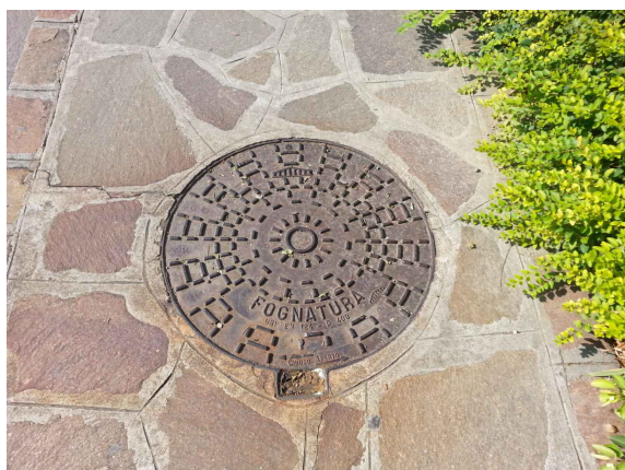
Foto 1 - Botola in ghisa sferoidale
