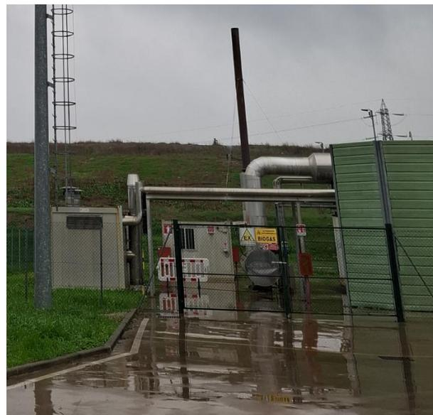
Dettaglio serbatoio criogenico N<sub>2</sub> liquido (sx); cogeneratore in container e torcia (dx)
