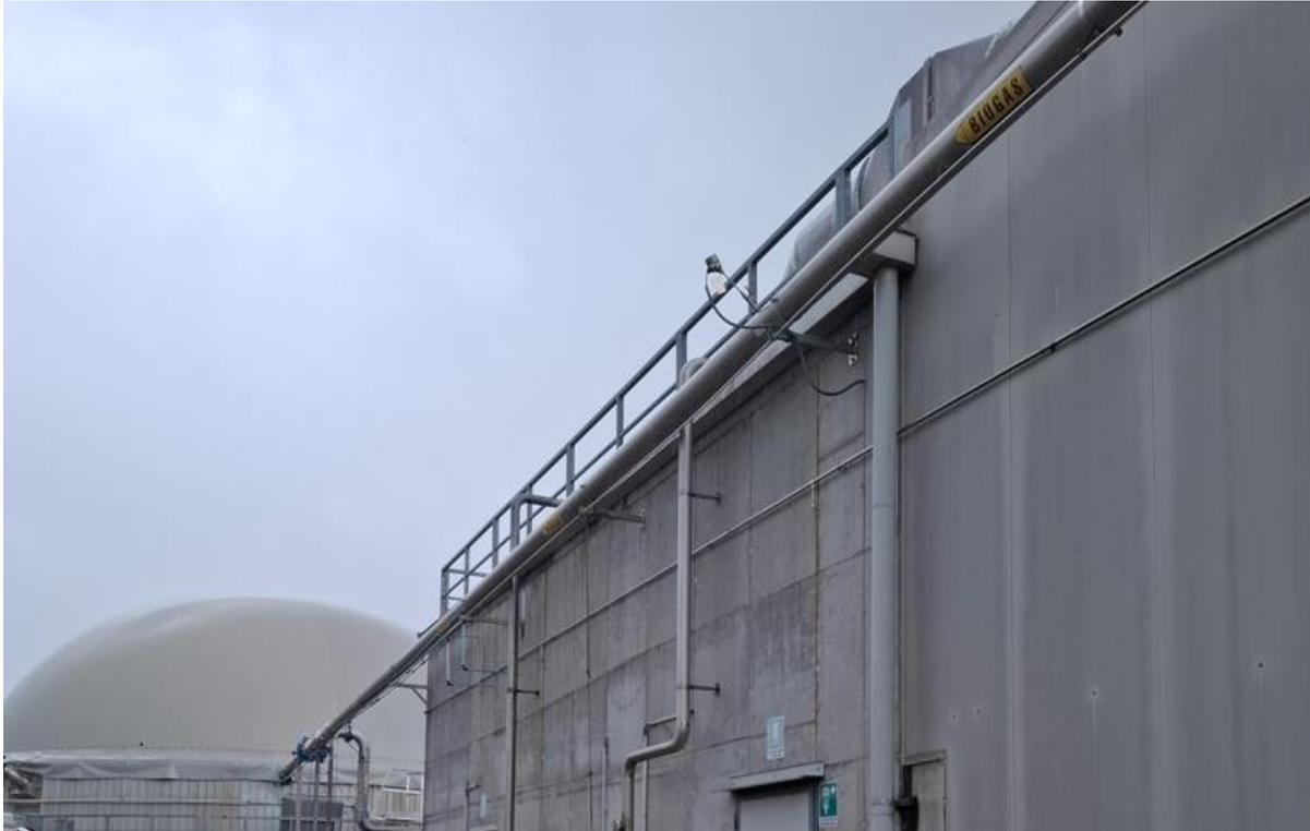
*Dettaglio tubazione di trasporto biogas (esterna) da digestore anaerobico al fermentatore*
