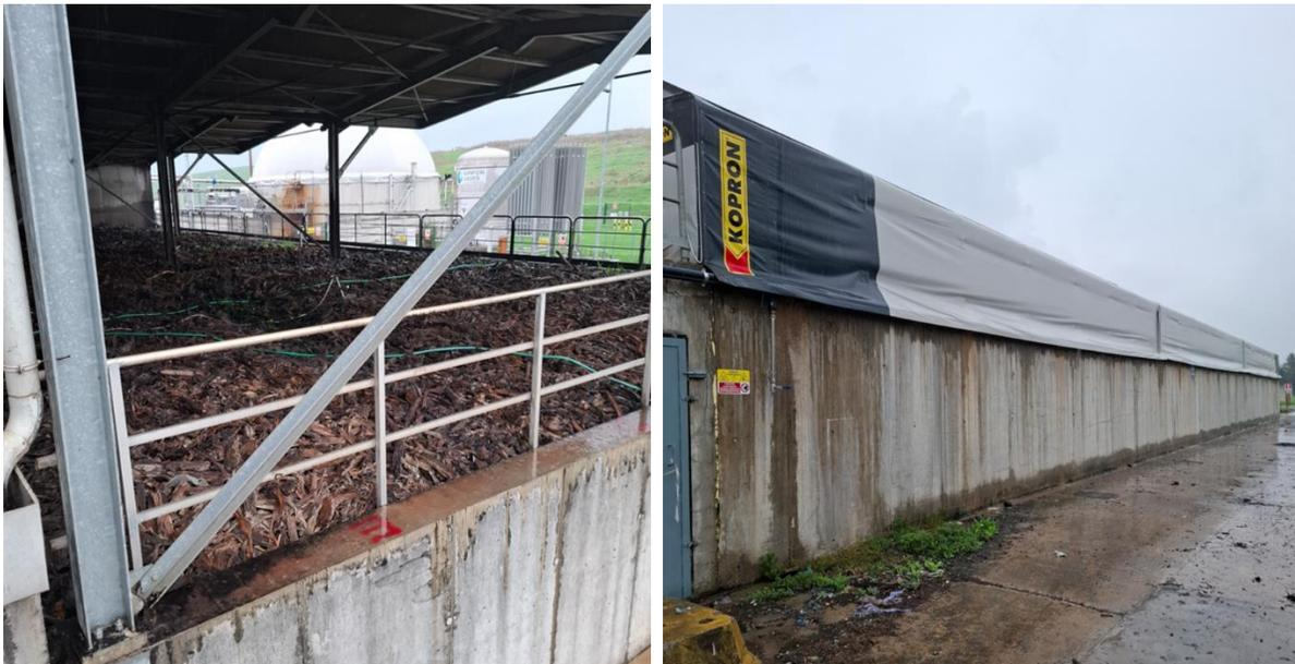
*Dettaglio biofiltro E4 con copertura fissa in carpenteria e pannelli sandwich (sx); biofiltro E3 con dettaglio copertura in telo di poliolefina “kopron”*
