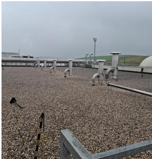
Dettaglio arrestatore di fiamma tra digestore e fermentatore (sx); valvole di sovrappressione in copertura del fabbricato che ospita le celle o reattori anaerobici (dx)
