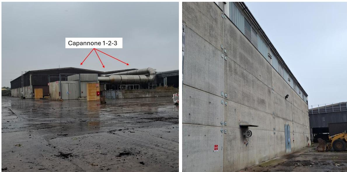
*Dettaglio: fabbricato digestione aerobica; vista laterale capannoni 1-2-3 e tubazioni impianto di ventilazione stabilizzazione rifiuto; parete esterna fabbricato selezione (con in evidenza interventi antisismici)*
