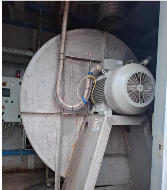
*Scrubber, dettaglio cabinato soffiante e biofiltro E3 (digestione aerobica)*
