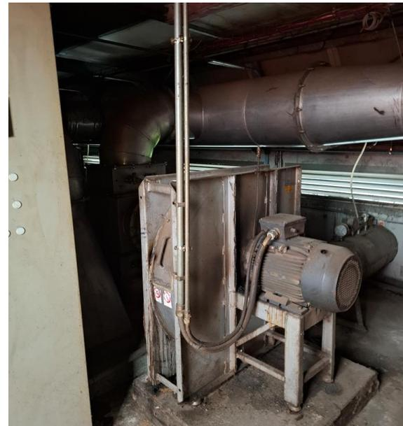
Copertura fabbricato digestione aerobica(bio-ossidazione): dettaglio impianti di ventilazione
