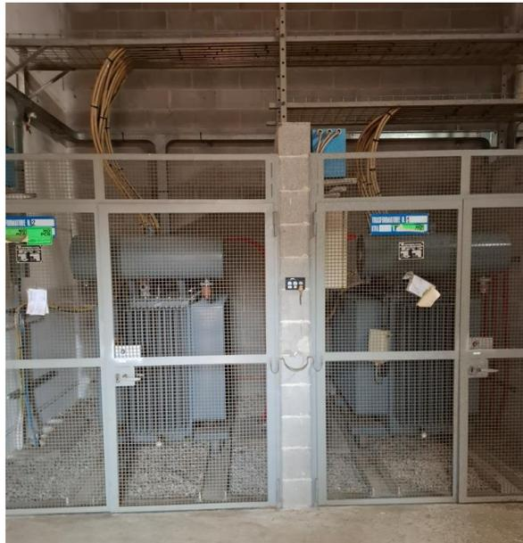
*Dettaglio GE fabbricato digestione anaerobica (sx); trasformatori isolati in olio in cabina n.1 (dx)*
