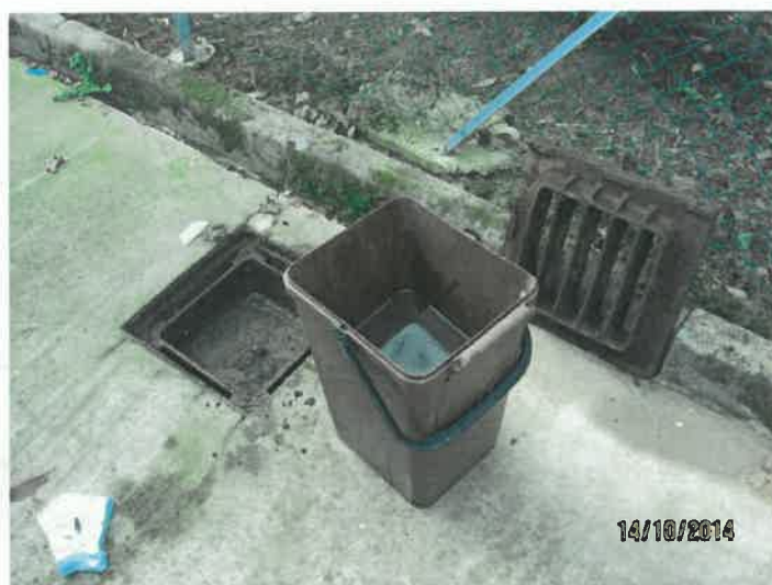
Figura 6 Secchiello con acqua per ultimare la pulizia e verificare il corretto funzionamento
