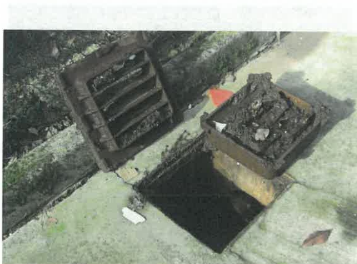
Figura 3 Estrazione vaschetta di decantazione
