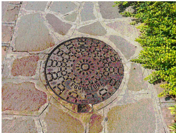
Foto 1 - Botola in ghisa sferoidale
