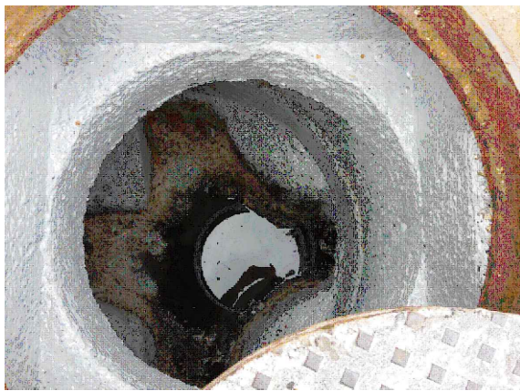
Foto 7 - Ripristino pareti e fondo con resina epossidica
