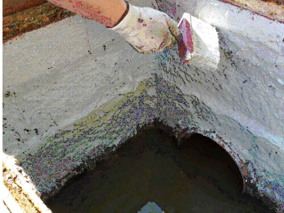
Foto 5 - Ripristino pareti e fondo con malta cementizia
