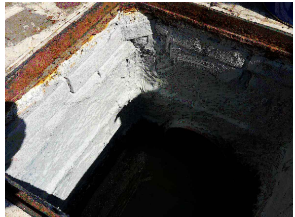
Foto 6 - Ripristino pareti e fondo con malta cementizia
