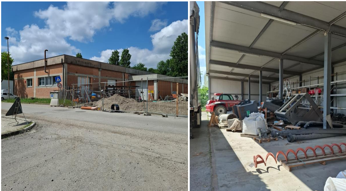
Unità 11: magazzino centrale (sx) e tettoia esterna per materiali di risulta (dx)
