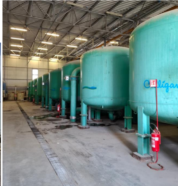
Unità 8: fabbricato impianto filtrazione (sx) e dettaglio interno con la batteria di filtri (dx)
