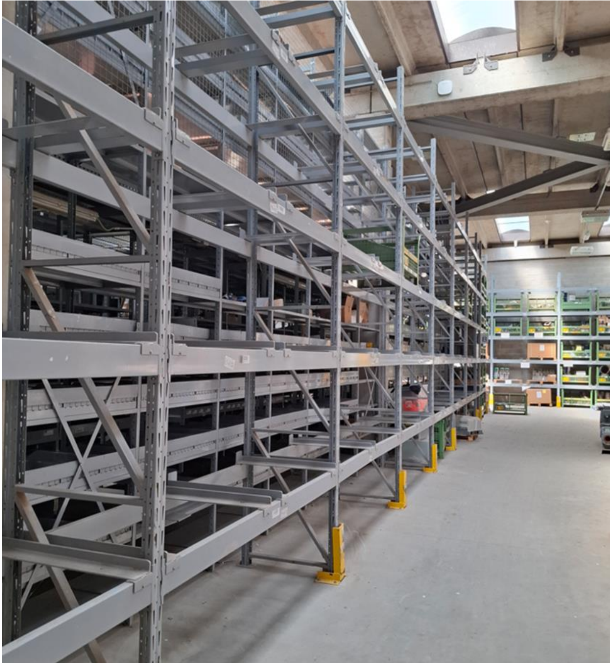
Unità 11: magazzino centrale con dettaglio collegamento travi-pilastri e controventi in copertura (sismica)
