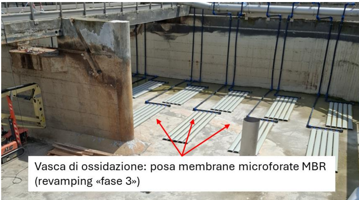
Figura 1: posa membrane MBR sul fondo vasca ossidazione centrale (depuratore)
