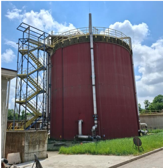
Unità 5: impianto trattamento fanghi, digestione anaerobica (sx) e torcia di sicurezza (dx)
