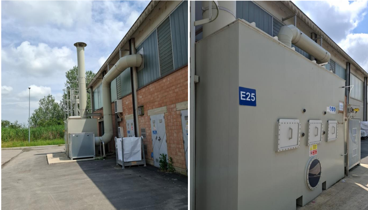
Dettaglio nuovo scrubber (punto di emissione E25) con controllo “delta P” per abbattimento emissioni nuovo conferimento D8 e trattamento chimico fisico D9
