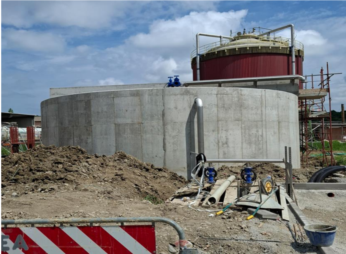
Figura 2: dettaglio dismissione/revamping impianto di digestione anaerobica
